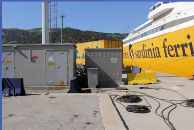
Cold Ironing porto di Vado Ligure Potenza 1,5 MW - Tensione 380 V a 50 Hz Possibilità di alimentare fino a 3 traghetti di grandi dimensioni
