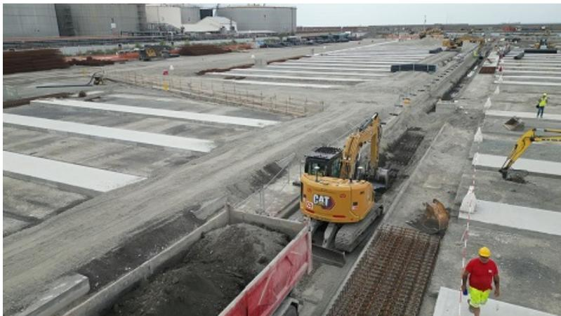
**A Calata Bettolo, nel cuore del porto di Genova, i lavori di ampliamento del terminal procedono a ritmo sostenuto. Sono quasi completate le travi slab sulle quali verranno posizionati i container ed è in corso la posa dei sottoservizi.**
