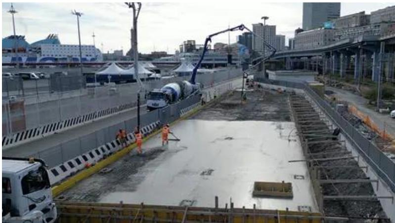
**Nella giornata di ieri è stata completata la prima parte delle fondazioni destinate ad ospitare la cabina che conterrà i quattro trasformatori necessari all'elettrificazione completa di tutte le banchine crociere e traghetti del porto di Genova.**
