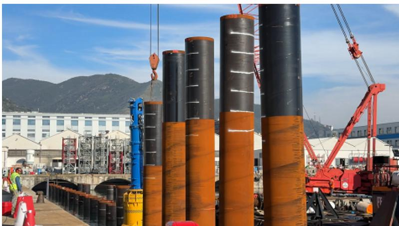
**Proseguono a Genova Sestri Ponente i lavori per la nuova banchina di allestimento destinata a potenziarne l'attività industriale, attraverso l'infissione di 269 pali di fondazione con tecniche avanzate e sicure.**
