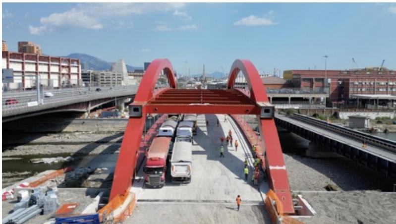
**Sono terminate ieri le prove di carico sul nuovo Ponte del papa, il viadotto a due piani sul torrente Polcevera che rappresenta l'anello di smistamento e di indirizzamento dei traffici su gomma per l'intero varco di Ponente del porto di Sampierdarena.**
