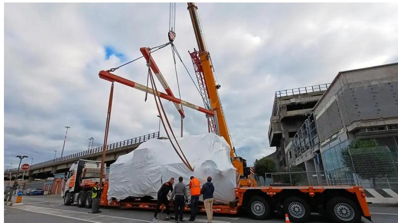
**Nel porto di Savona è arrivato in cantiere nei giorni scorsi il nuovo dispositivo AMP Mobile “PowerMove”, che diventerà il cuore del sistema di elettrificazione delle banchine dedicate al traffico passeggeri, segnando una tappa decisiva nell'avanzamento del progetto di cold ironing del terminal crocieristico.**
