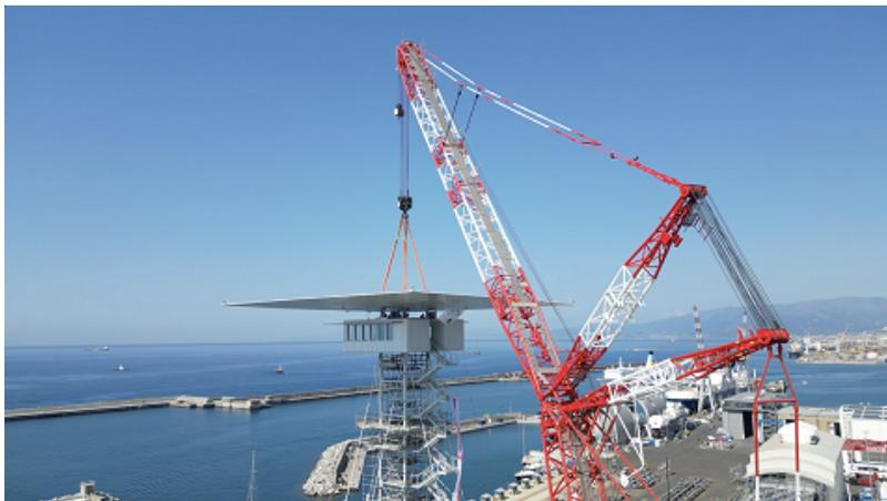
**La copertura della nuova Torre Piloti, nell’area di levante del porto di Genova, è stata issata a 65 metri di altezza e posizionata al di sopra della cabina di controllo attraverso complesse operazioni di sollevamento, rese ancora più delicate dai ristretti spazi di manovra dei mezzi di cantiere tra le banchine e lo specchio acqueo, e dalle imponenti dimensioni della struttura metallica, un quadrato di quasi 800 metri quadri per 150 tonnellate di peso.**
