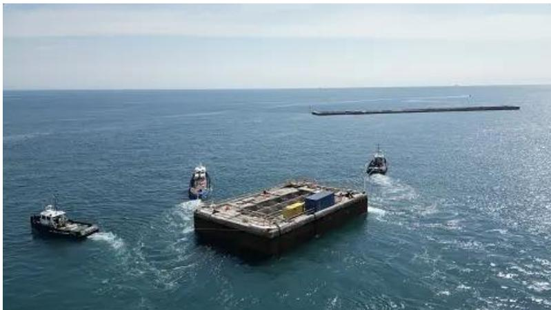
**Sono in fase di avanzamento i lavori per la realizzazione della nuova diga a protezione del bacino portuali di Vado Ligure. Con il recente collocamento dell'ottavo cassone si riduce ulteriormente la distanza tra l'infrastruttura esistente e quella nuova che diventeranno un'unica opera foranea.**
